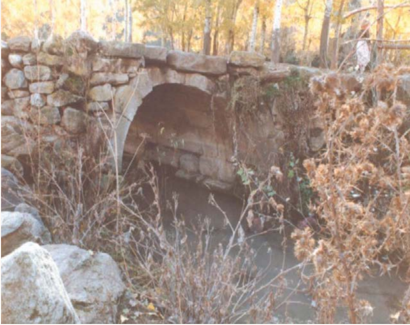
Balıkuyumcu Roma Köprüsü (Fot: AKTVK Kurulu Arşivi)
