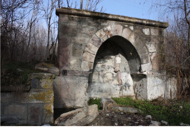
Faharet Çeşmesinin Bugünkü Durumu (2017) Fot. Gökçe Günel
