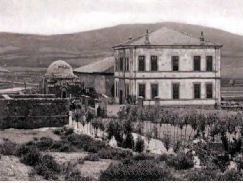
Ek 2: Kızıl Bey Külliyesi (Önde iki katlı bina Reji İdaresi; Tarih İçinde Ankara, s.144)
